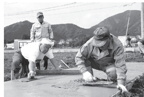
稲葉崎地区の作業風景
