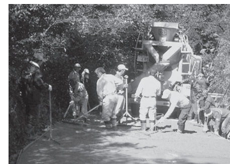
下三輪地区の作業風景
